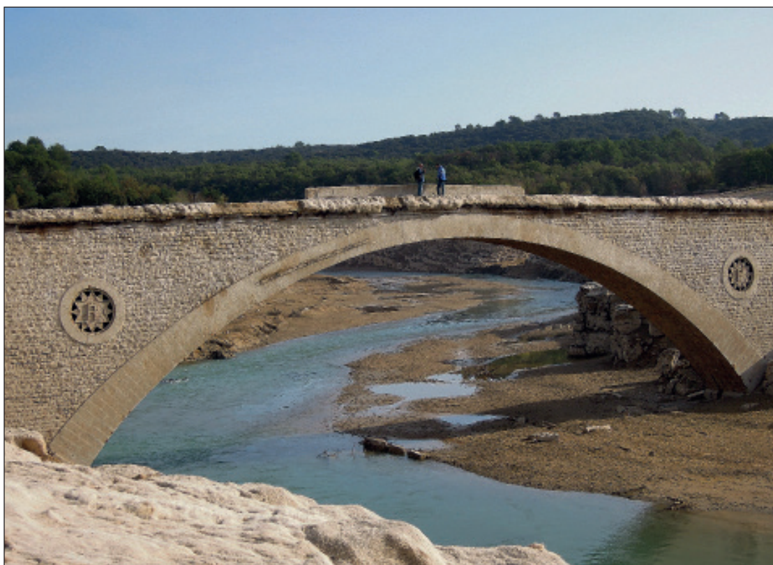
Le pont englouti dans la retenue de Montpezat-Quinson, qui a revu la lumière le temps d'une vidange.
